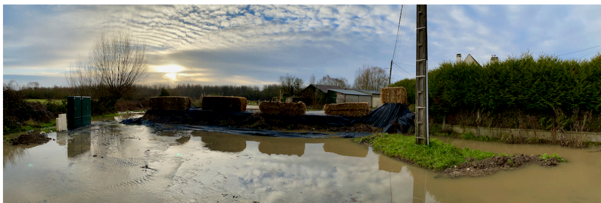
Rue des Haudoirs, vu depuis l'amont, ballots de paille. A gauche, armoire électrique à sécuriser.
